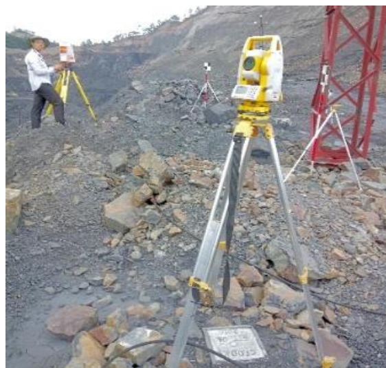
Hình 6. Máy quét GeoMax Zoom 300 và bảng tiêu được bố trí phục vụ một trạm quét tại mỏ Cọc Sáu.
